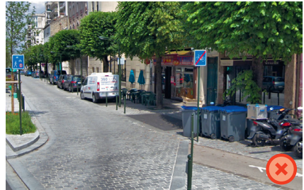
▲ Bourg-la-Reine, avenue du Général Leclerc : la piste est interrompue par la contre-allée avec un revêtement pavé inconfortable pour les vélos et des pictogrammes incitant à rouler le long des portières : les vélos entrent dans le domaine des voitures (qui n'ont quasiment aucun indice de leur présence éventuelle). (Google Street View)
