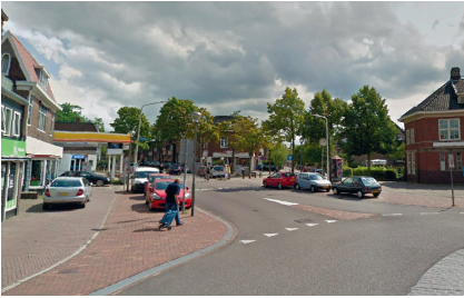
▲ Nimègue (Pays-Bas), Daalseweg : la bande cyclable dans l'anneau a été supprimée en 2017 pour ne pas favoriser une mauvais positionnement des vélos. Mieux vaut rien qu'une bande cyclable dans un giratoire... (Google Street View)
