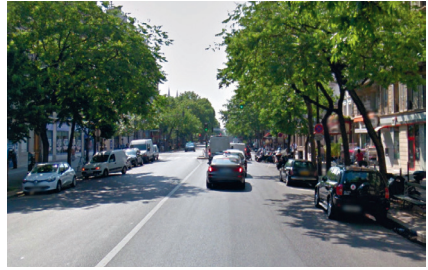
▲ Paris 11 e , boulevard Voltaire : le boulevard en 2015, avec stationnement bilatéral et deux files de circulation non marquées. La création de pistes cyclables a été permise par le passage du boulevard à 2×1 voie. (Google Street View)
