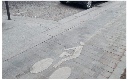
▲ Paris 13 e , rue Croulebarbe : des pavés sciés sont utilisées pour la piste, plutôt que les pavés parisiens classiques inconfortables qui jalonnent la chaussée. (Paris en Selle)
