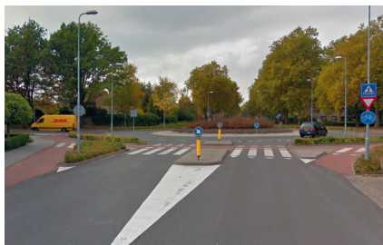
▲ Veldhoven (Pays-Bas), De Beemb : une branche apaisée connectée au giratoire par des amorces de pistes sans aucun seuil, ni bordure, ni fil d'eau. (Google Maps)
