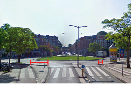
▲ Amsterdam (Pays-Bas), Frederik Hendrikstraat : la sortie de l'anneau cyclable s'effectue quelques mètres en amont du croisement entre l'anneau cyclable et la chaussée pour améliorer la prévisibilité de la trajectoire vélo. Un tel espacement n'est pas nécessaire de l'autre côté. (Google Street View)
