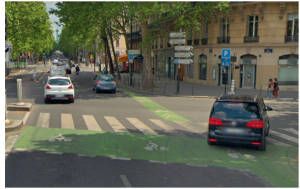
▲ Paris 4 e , pont de Sully : un sas vélo (coloré) qui remplace abusivement une simple ligne d'arrêt reculée. Aucun vélo ne va se positionner dans le sas devant le trafic motorisé puisque le tourne-à-gauche n'est pas possible à ce carrefour. (Google Street View)
