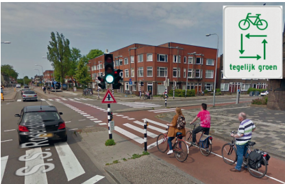
▲ Groningue (Pays-Bas), S.S. Rosensteinlaan : le tout-vert cycliste est annoncé par un panneau. Pas d'îlot de coin nécessaire et une attente des vélos avant le passage piéton avec une file de présélection pour laisser libre le tourne-à-droite qui est autorisé au rouge. (Google Street View)
