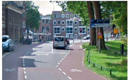
▲ Utrecht (Pays-Bas), Tolsteegsingel : pour certaines intersections (ici avec feux), le besoin de stockage du trafic motorisé implique le retour à une chaussée double avec des bandes cyclables. (Google Street View)
