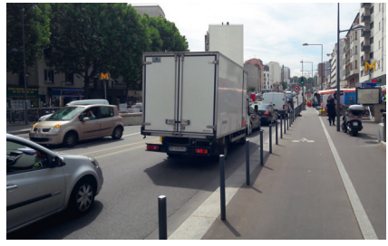
▲ Villejuif, avenue de Paris : les potelets sont une solution assez efficace et très économique pour sanctuariser une piste. Une bordure peut toutefois être aussi efficace tout en étant plus confortable et moins dangereuse. (Paris en Selle)
