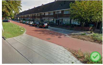
▲ Bois-le-Duc (Pays-Bas), Graafseweg : la piste se transforme en contre-allée, à laquelle les voitures accèdent par un trottoir traversant en perdant toute priorité : les voitures entrent dans le domaine des vélos. (Google Street View)
