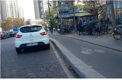
▲ Paris 13 e , place d'Italie : la piste se situe à niveau intermédiaire, avec un séparateur de 15 cm de haut côté chaussée, dissuasif envers le stationnement sauvage. (Paris en Selle)
