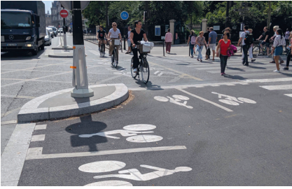
▲ Paris 1 er , croisement Rivoli-Sébastopol : deux axes du REV se croisent avec un traitement de l'intersection qui sécurise les traversées et offre une bonne capacité. (Paris en Selle)
