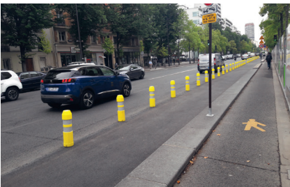
▲ Paris 13 e , avenue d'Italie : pendant les travaux du centre commercial, un nouveau cheminement cyclable sécurisé est créé à la place du stationnement. (Paris en Selle)
