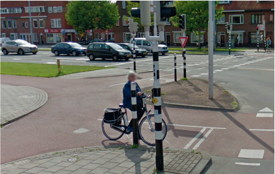
▲ Utrecht (Pays-Bas), Vleutenseweg : le cheminement cyclable en enrobé rouge dispose de son propre domaine de voirie, qui n'est ni le trottoir ni la chaussée. Comme le trafic motorisé, les vélos n'ont pas à franchir de caniveau ou des bordures. (Google Street View)
