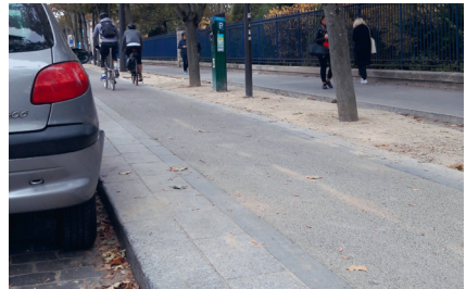
▲ Paris 14 e , boulevard Jourdan : l'espace tampon (65 cm) à niveau de la piste maximise sa largeur. (Paris en Selle)
