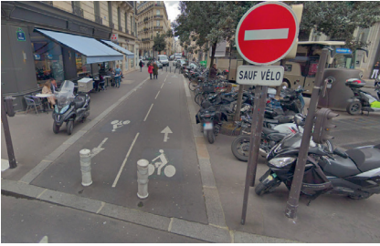
▲ Paris 9 e , rue de Provence : les potelets en métal (encore visibles au fond) ont été remplacés par des plots en plastique, moins dangereux en cas de collision d'un vélo, mais placés en plein sur leur trajectoire. (Google Street View)
