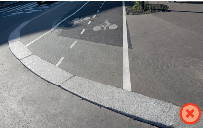
▲ Paris 4 e , boulevard Morland : la vue n'est pas à zéro, avec un seuil inconfortable, voire dangereux. (Paris en Selle)
