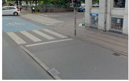
▲ Copenhague (Danemark), Gothersgade : la piste dispose de son propre domaine à mi-niveau avant de rejoindre la chaussée aux intersections principales, sans croiser de bordure. La chaussée et la piste ont chacune leur fil de l'eau. (Google Street View)
