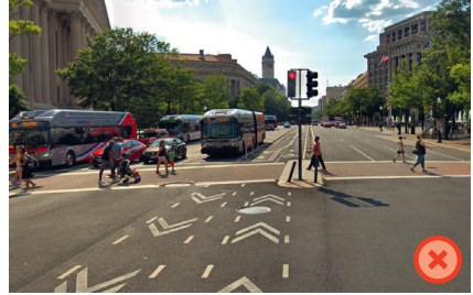
▲ Washington DC (États-Unis), Pennsylvania Avenue : la piste bidirectionnelle est implantée au centre d'une avenue avec 8 files de circulation motorisée. (Google Street View)
