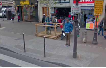
▲ Paris 18 e , boulevard Barbès : la piste cyclable déjà peu distincte du trottoir s'interrompt au droit du passage piéton, ce qui accentue les conflits piéton-vélos. (Google Street View)
