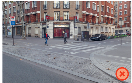
▲ Paris 14 e , boulevard Jourdan : la petite rue transversale est censée avoir la priorité sur la piste et le boulevard (priorité à droite), alors que la présence d'un plateau traversant suggère une priorité à la piste, immédiatement contredite par la bordure de trottoir en travers de la piste, qui elle suggère une priorité à la chaussée. (Paris en Selle)
