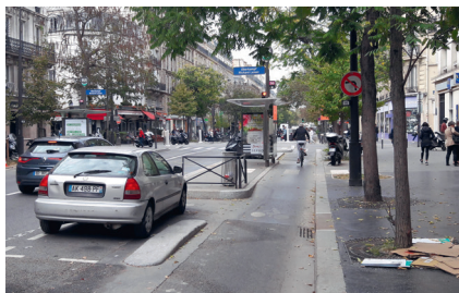
▲ Paris 11e, boulevard Voltaire : la piste longe le trottoir et passe derrière le quai bus avec abri avec un plateau traversant pour favoriser la traversée piétonne des usagers du bus. (Paris en Selle)
