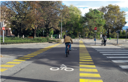
▲ Grenoble, rue de Stalingrad : la piste cyclable se prolonge dans l'intersection avec un marquage de rive bien visible. (Paris en Selle)
