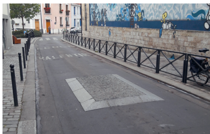
▲ Paris 13 e , rue du Dr Laurent : un coussin berlinois permet de ralentir les voitures, mais pas les scooters ni les motos. Les vélos le contournent aisément mais les vélocargos et tricycles peuvent être gênés si l'espace latéral est limité. (Paris en Selle)
