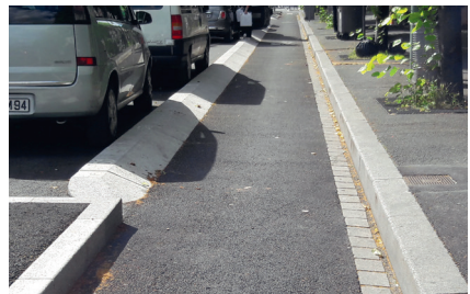
▲ Arcueil, avenue Laplace : le séparateur de 70 cm est chanfreiné, ce qui réduit l'effet paroi, qui reste néanmoins présent côté trottoir. (Paris en Selle)
