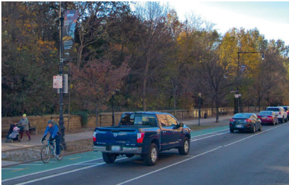
▲ New York (États-Unis), Prospect Park West : une piste bidirectionnelle de 3,00 m de large est séparée du stationnement par un espace tampon peint au sol de 1,00 m. (Google Street View)
